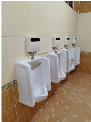
เลือกใช้สุขภัณฑ์ประหยัดน้ำและติดตั้งเซนเซอร์โถปัสสาวะอัตโนมัติ บริเวณโซนห้องน้ำชาย
