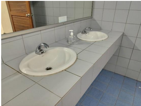
ติดตั้งวาล์วน้ำอัตโนมัติที่อ่างล้างมือ
