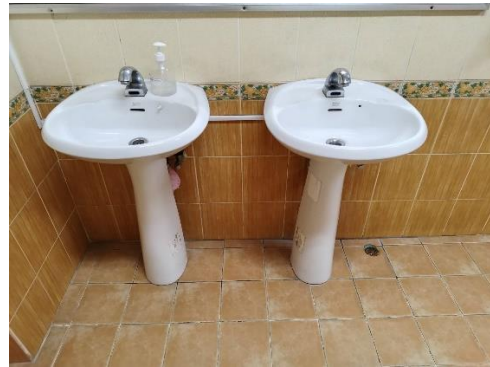
ติดตั้งวาล์วน้ำอัตโนมัติที่อ่างล้างมือ
